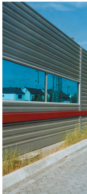
LÄRMSCHUTZWAND BEI TROISDORF (D)
