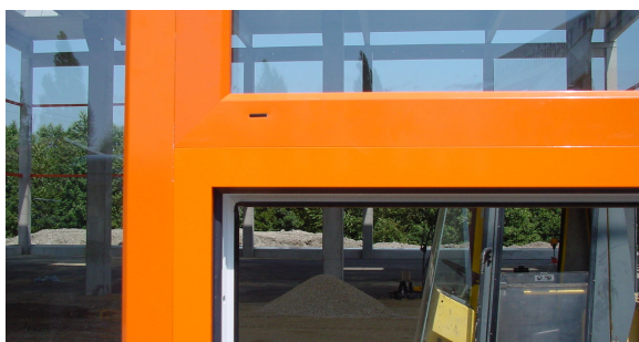
Abb. 4.1.1 Farbdifferenz durch unterschiedliche Schichtdicken
